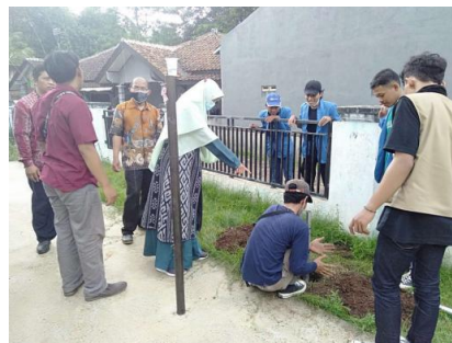
Gambar 2. Kondisi lokasi sebelum pemasangan PJU
