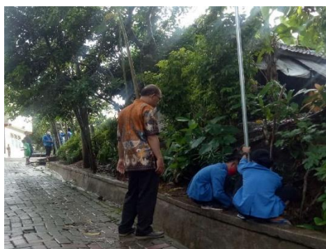
Gambar 3. Proses pemasangan sistem PJU berbasis solar panel
