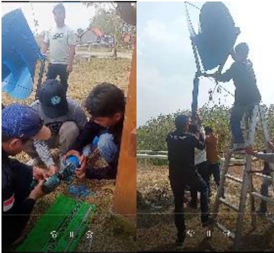
Gambar 9. Pemasangan Turbin Angin Archimedes, (kiri) Perakitan, (kanan) Instalasi
