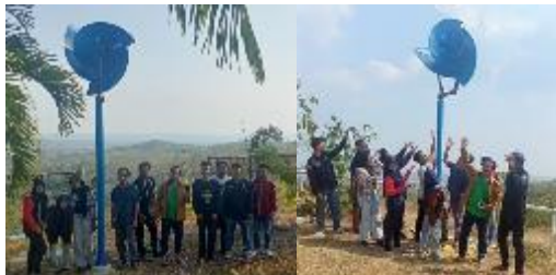
Gambar 11. Turbin Angin Archimedes telah terpasang di 2 lokasi
