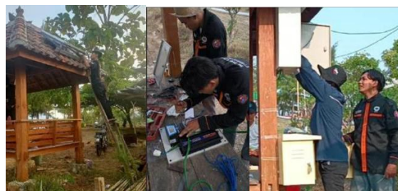
Gambar 8. Pemasangan PLTS dan Komponennya
