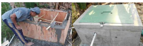
Gambar 7. Pembangunan Rumah Pompa oleh Mitra
