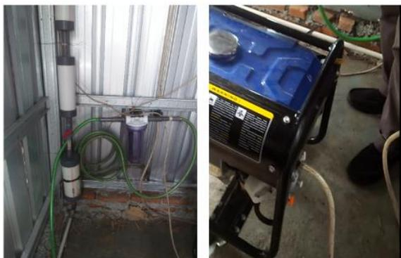
**Gambar 5.** Instalasi teknologi yang dikembangkan dengan pipa dari *digester*.
