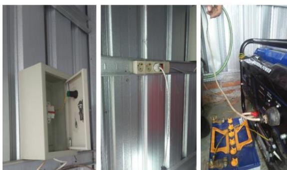
**Gambar 6.** Instalasi penyaluran energi listrik biogas ke sistem beban di mitra.
