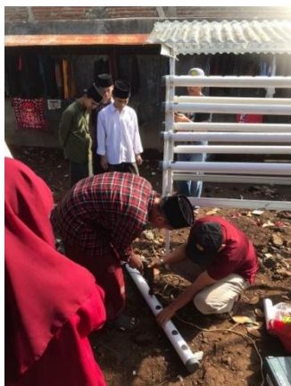
Gambar 2. Pembuatan instalasi hidroponik
