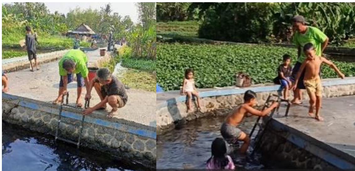
Gambar 6. Pemasangan dan ujicoba tangga keselamatan [19]
