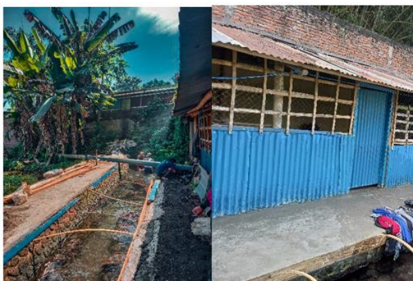
Gambar 3. Plengsengan dalam proses perbaikan [18]
